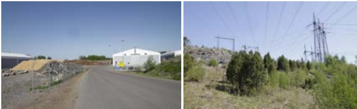
Bild 25. Till vänster lagerbyggnaderna norr om Kraftverksvägen. I omgivningen runt dem lagras stockar under bar himmel. Till höger kraftledningarna på kullen norr om elstationen. Kullens krön ligger 41 meter ovanför havsytan. Foto: FCG, Minttu Kervinen, 24.5.2023.
