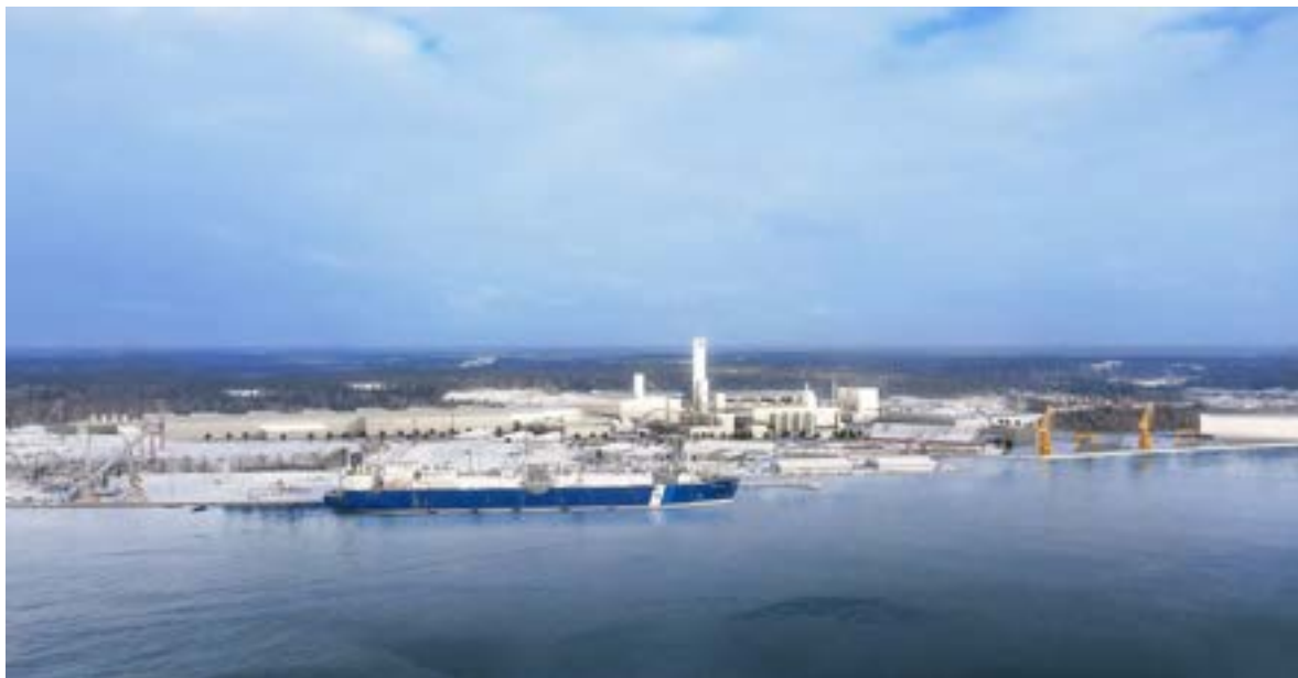
Bild 45. Illustration av det planerade gröna stålverket och det omgivande området. I fabriksområdets mitt syns direktreduceringsanläggningen, med en bygghöjd på cirka 135 m, där järnmalmspellets med hjälp av vätgas reduceras till järnsvamp (DRI).
