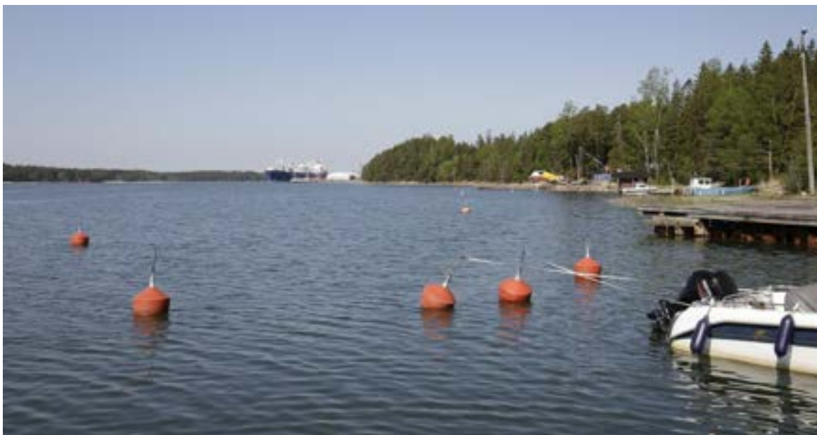
Bild 31. Utsikten från Fiskehamnen mot väster. LNG-terminalfartyget dominerar utsikten på Norrfjärden. På stranden mellan Fiskehamnen och Djuphamnen finns en skogbevuxen kulle och en vall som skymmer de bakomliggande brytnings-, lagrings- och deponiområdena. Foto: FCG, Minttu Kervinen, 24.5.2023.
