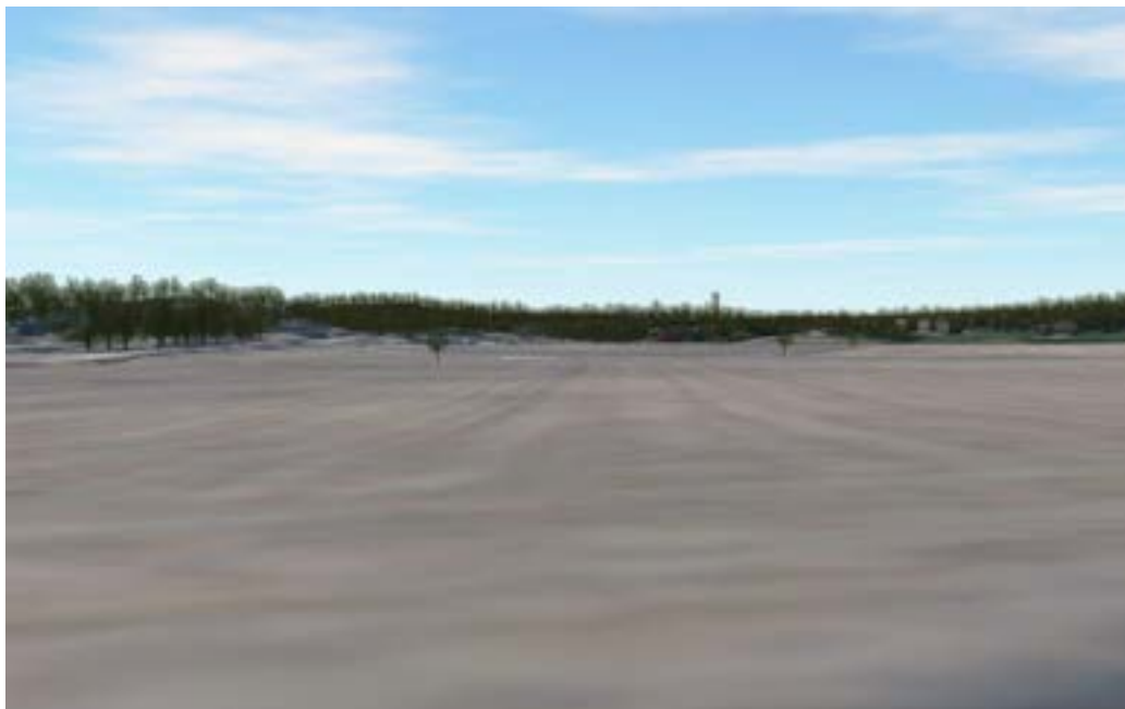
Bild 61. Illustration från nordväst efter att planlösningen genomförts. Stålverkets högsta byggnad, direktreduktionstornet, syns ovanför trädtopparna i mitten av bilden.
