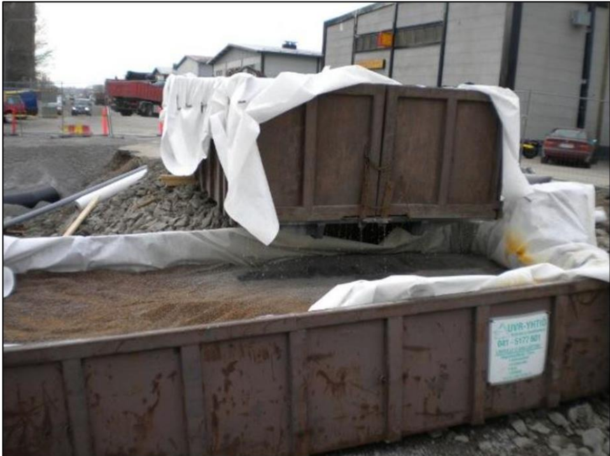
Kuva 15 Esimerkkikuva vaihtolavan sisään rakennetusta suodattimesta. 5
